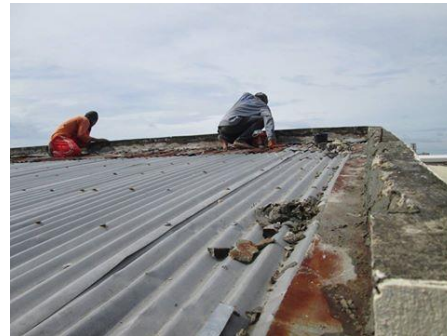
Dacharbeiten „in heißen Höhen“...
